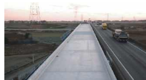
新4号総和高架橋床板 | 茨城県 境町
