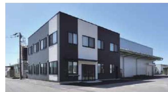
大泉塗工(株) 事務所・倉庫 | 群馬県 千代田町
