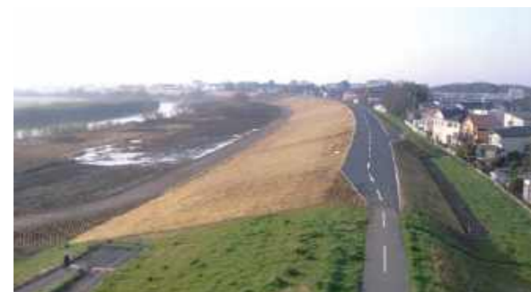
新宿新田地区築堤 | 埼玉県 春日部市
