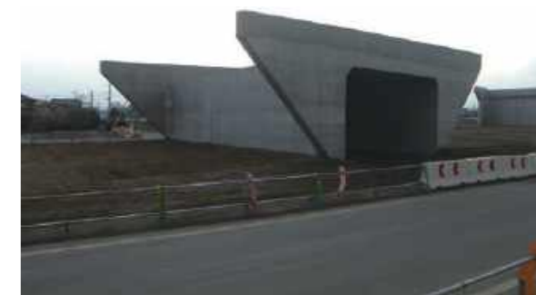
上武道路函渠 | 群馬県 前橋市
