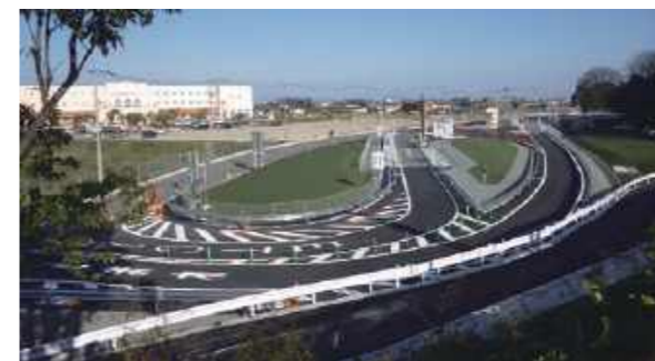
関越上里スマートIC | 埼玉県 本庄市
