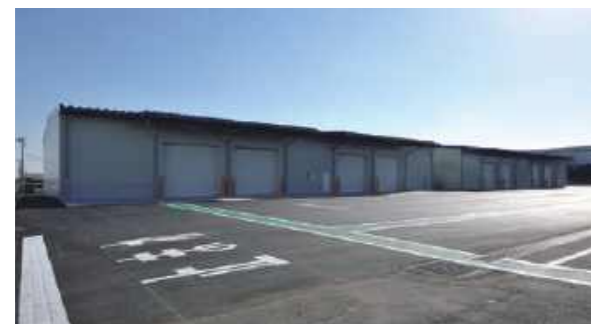
日本通運(株) 館林危険物倉庫 | 群馬県 館林市
