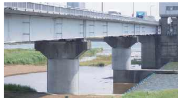
利根大堰耐震補強 | 群馬県 千代田町
