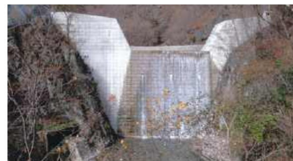
安蘇沢三号砂防堰堤 | 栃木県 足尾町
