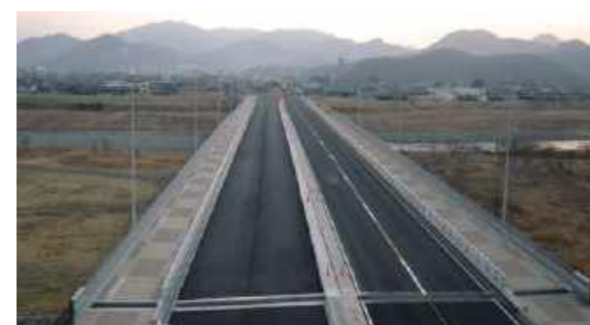
中通り大橋上部工床板 | 群馬県 桐生市
