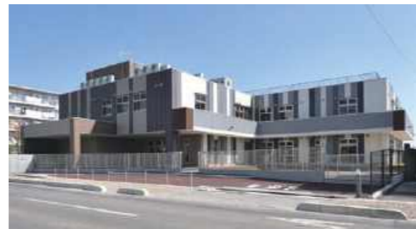
しらぎく幼稚園 | 埼玉県 上尾市
